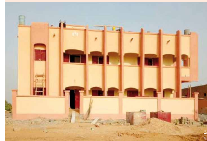
» Baumaßnahme Frauenschutzhaus in Gao (Stand Okt. 2018)
